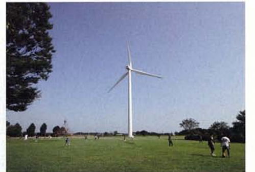
千葉県旭市で運転中の市民風車「かざみ」。予測発生電力量は320万kWh/年で、一般家庭約1000世帯分の年間消費電力に相当。
